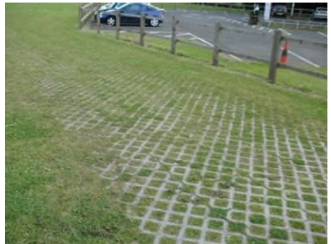
Exemples de revêtements perméables et carrossables
